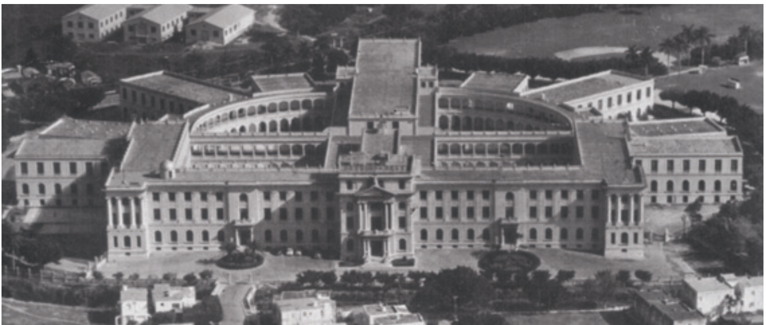
Le Collège Belen à La Havanne (avant 1951)
